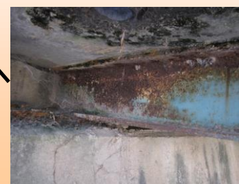
鋼桁の損傷（腐食）
